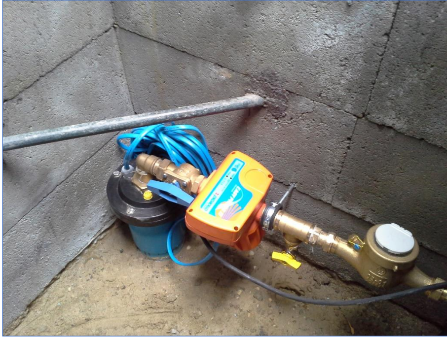
4. ábra : Szakszerűen kialakított zárt kútfej
