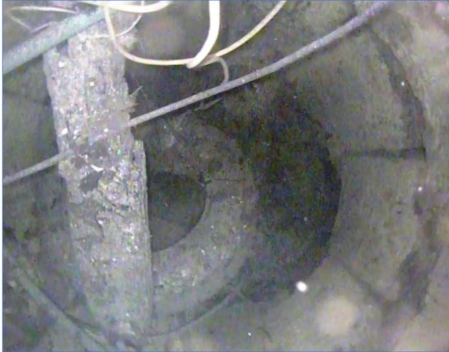
3. ábra: Kútkamerás felvétel egy ásott kút belsejéről
