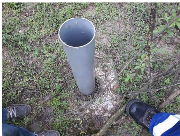
Lezáratlan monitoring kút (a PVC-rakat védelmét biztosító acélsövet és a zárósapkát eltulajdonították) (a szerző saját felvétele, 2019.)
