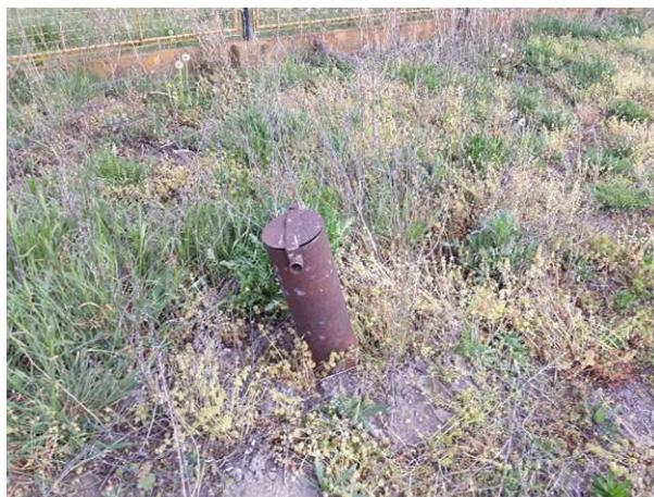
Részben „kiszántott” monitoring kút (a szerző saját felvétele, 2019.)
