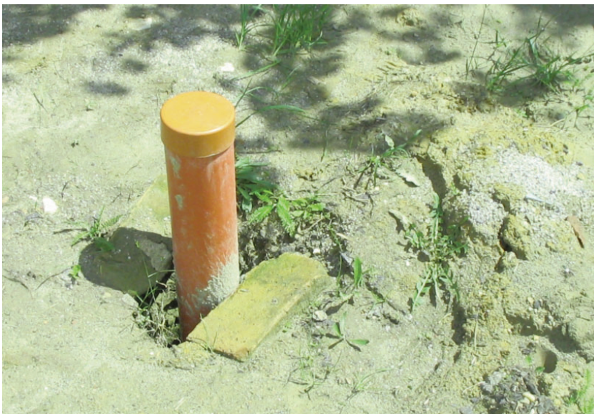
1. kép. Egy rakatos, vékonyfalú műanyag csövezés, nem biztonságos kútlezárással. A kútpalást mellett szabad a víz útja lefelé [Faber L. felvétele]
