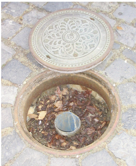
2. kép. A biztonságos kútfej lezárás itt is hiányzik [Faber L. felvétele]
