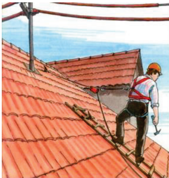
6. ábra Munkavégzés tetősíkon rögzített tetőlétráról
