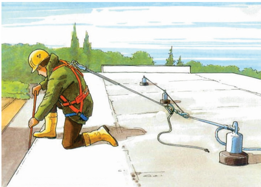
3. ábra Munkavégzés a födém szélének veszélyes közelében
